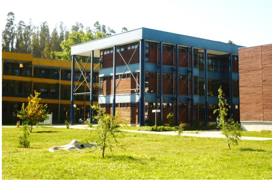
Figura 20. Edificio de aulas AB de la Universidad del Bío-Bío sede Concepción
