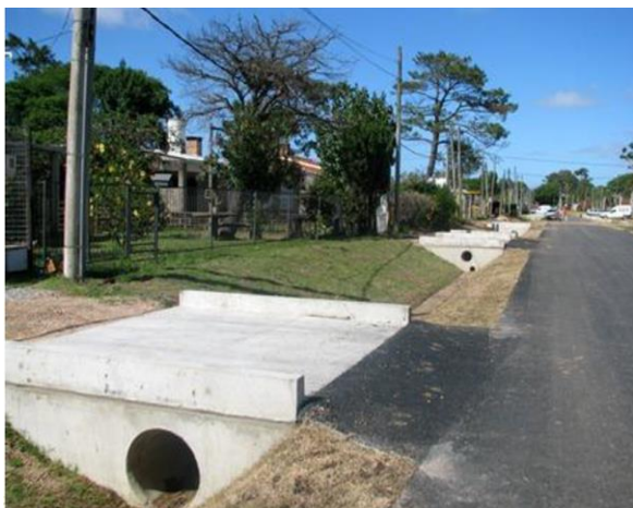
Figura 4 Cuneta amortiguadora, Ciudad de la Costa, Canelones.
