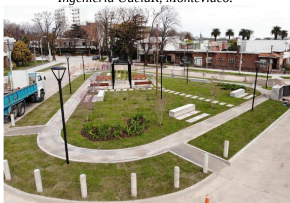
Figura 7 Plaza sobre tanque de retención subterráneo, Montevideo (Fuente: Intendencia de Montevideo).
