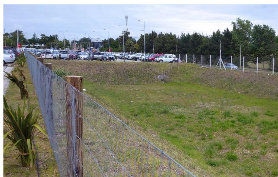
Figura 3 Laguna de retención sin espejo de agua permanente, Ruta Interbalnearia y Cno. Los Horneros, Canelones.
